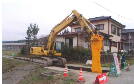
民家の近接部における改良施工
