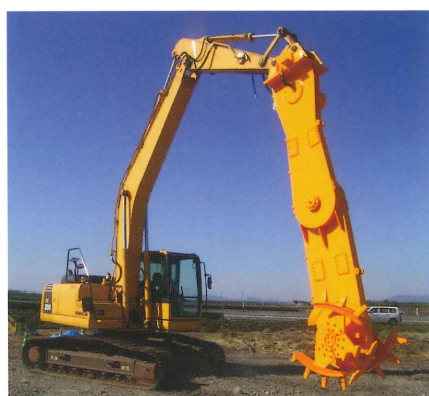
ブーメランプレート装着でN値38の礫混じり砂層に対応
